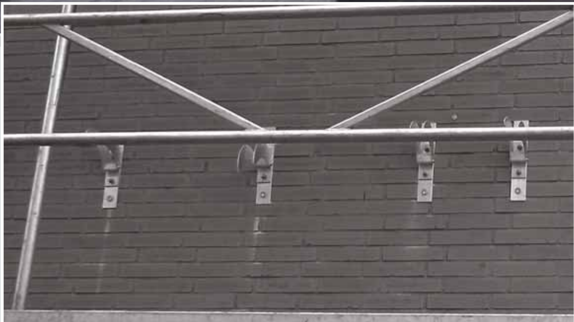
ConArcs mit Druckplatten an nicht belastbarer Fassade befestigt
